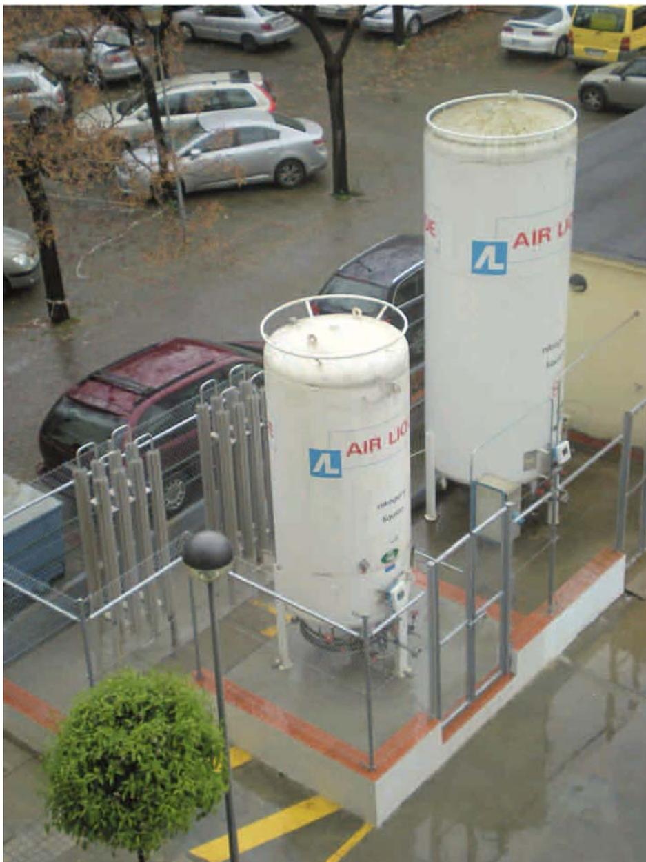
Figura 37: Tanques exteriores de Nitrógeno de 3.000 y 7.000 L.
