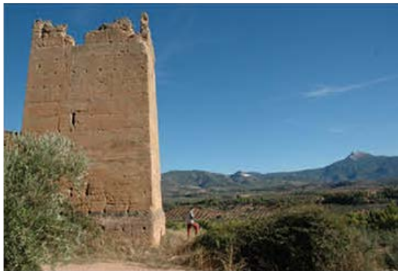
TORRE DEL CARDETE (BENATAE)
