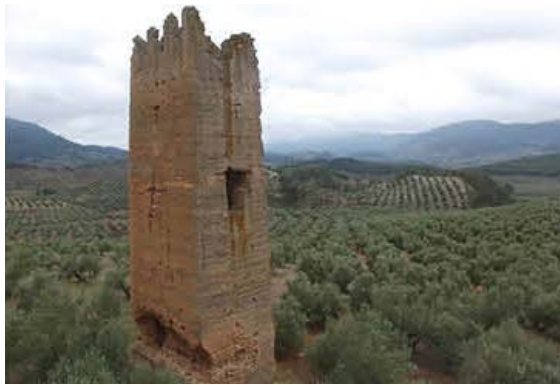
TORRE SUR DE SANTA CATALINA (ORCERA)
